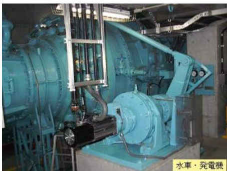
水車・発電機
