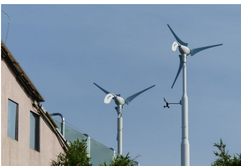
風車は直径1.8m。建物の構造も太陽エネルギー利用の家。夏は涼しく、冬は暖かい
