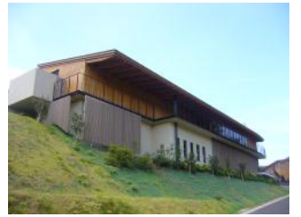
神奈川県産の木で造ったアカデミー棟 ～休息室や自販機、トイレ、農機具などがあり、主に生涯教育講座の受講生が使用する～
